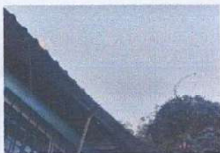
Foto 1: Sustitución de canal y baja de agua pluvial
