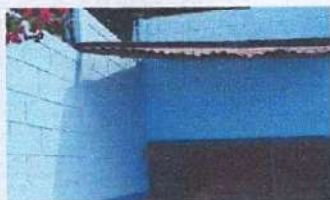
Foto 3: Cambio de cubierta y estructura en area de cocina
