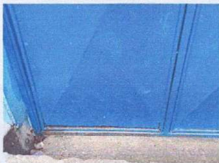
Foto1: Mantenimiento a Porton por picaduras en tubo y lamina
