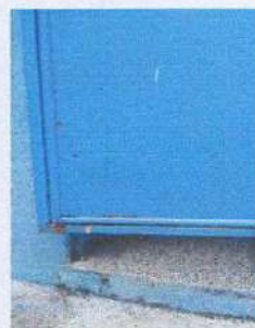
Foto 4: Mantenimiento a Puertas de baño
